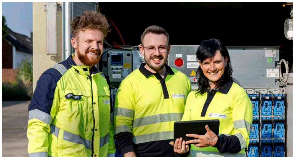
Julian Pauls, Simon Pfeiffer und Christina Denesiuk von der Leitungspartner GmbH an einer neuen Ortsnetzstation, die im Zusammenhang mit dem Um- und Ausbau der Netze errichtet wurde.
